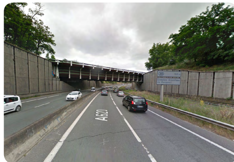
Franchissement du Canal du Midi
